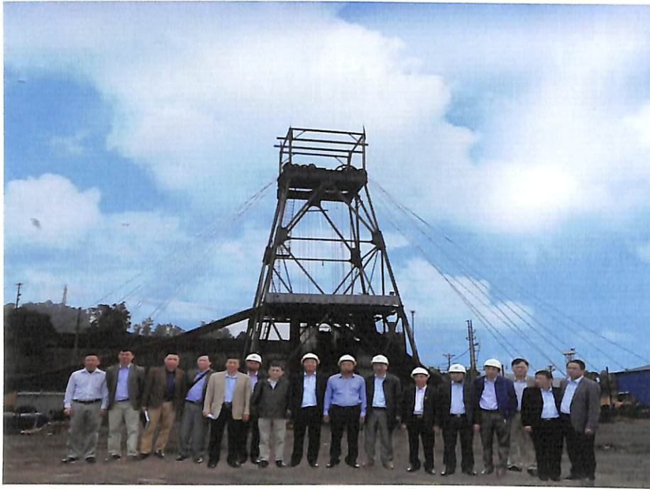
Tháp thi công giếng đứng thuộc dự án mỏ than hầm lò Núi Béo (do Viện KH-CN Mở tư vấn, thiết kế).
