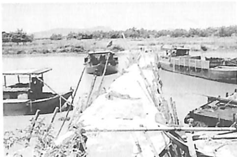
Hình 2. Hình ảnh đập ngăn mặn trên sông Vĩnh Điện vào mùa khô (trái) [9] Hình ảnh đập ngăn mặn trên sông Vĩnh Điện bị phá hủy khi mùa lũ (phải)
