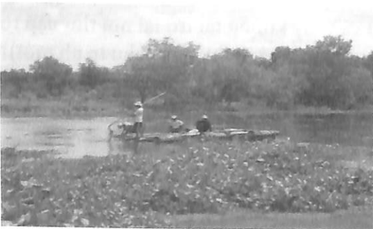
Hình 1. Sử dụng bè tre và câu liềm để cắt rong khơi dòng chảy trên sông thuộc hồ Dầu Tiếng, tỉnh Tây Ninh
