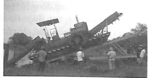
Hình 4. Triển hạ thủy đang thực hiện hạ thủy máy chính xuống sông để làm việc
