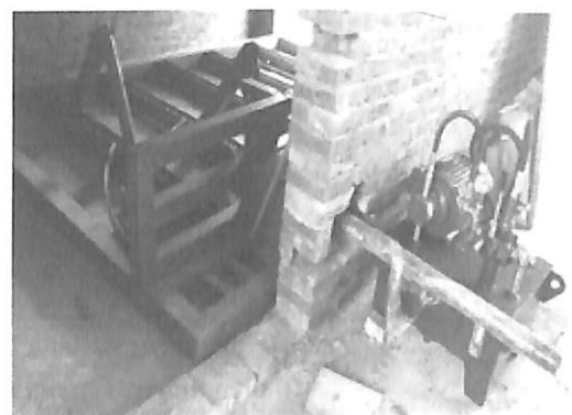
Hình 7. Hệ thống uốn gỗ
