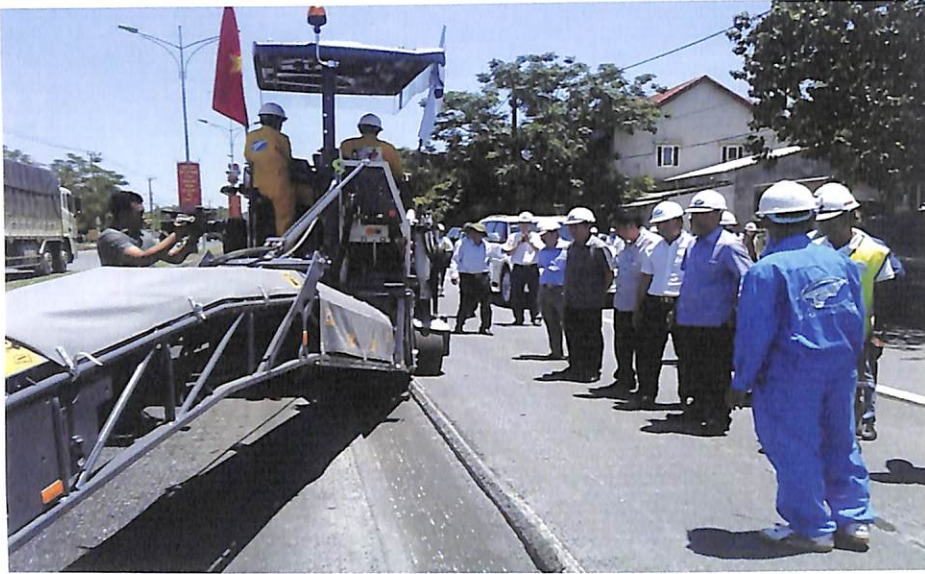
Công nghệ tái sinh nguội tại chỗ bằng bitum bột và xi măng đang được triển khai tại nhiều dự án giao thông ở Việt Nam.
