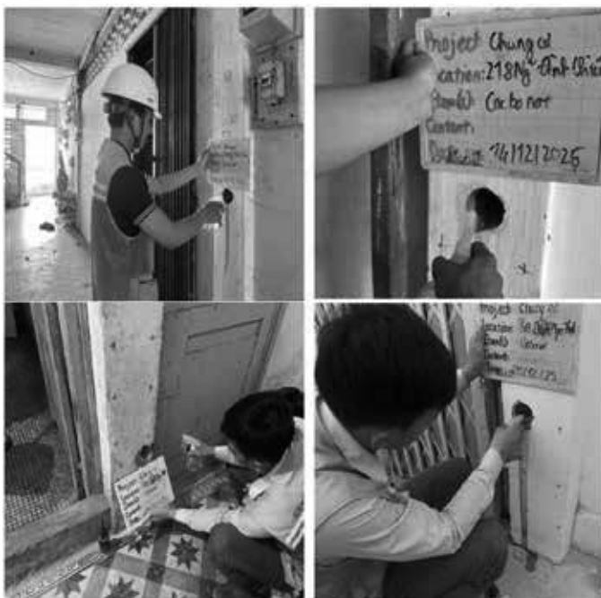
Hình 2. Hình ảnh thí nghiệm hiện trường đo chiều sâu cacbonat hóa bằng dung dịch phenolphthalein 1% tại các cấu kiện dầm và cột
